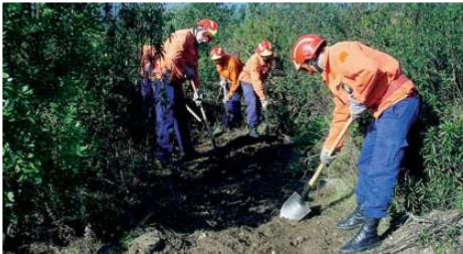
FIGURA 99: Faixa de contenção de incêndio construída com material de sapador.
