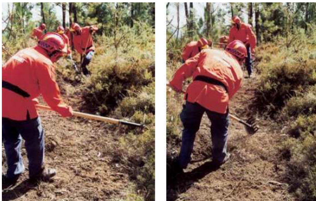
FIGURA 101: Abertura de faixa de contenção com material de sapador.
